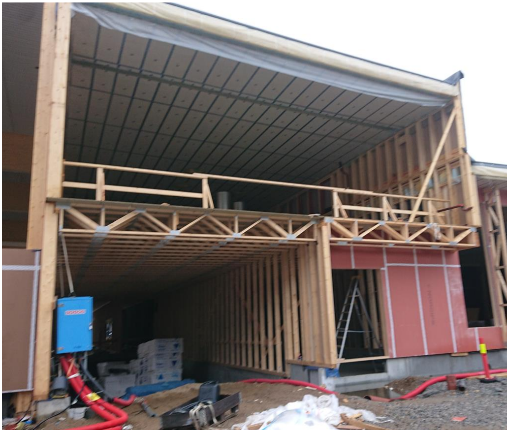
Bilete 3 Eksempel på bruk av gitterdragar som etasjeskiljar i skulebygg. Foto: Olav Klungre
