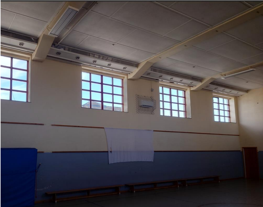
Bilete 9 Betongbjelkane kan ein sjå under himling
