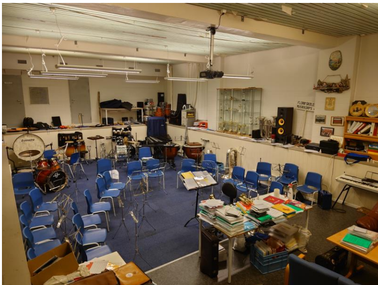
Bilete 5 Betongbjelkane kan ein sjå under himling. Foto: Olav Klungre
