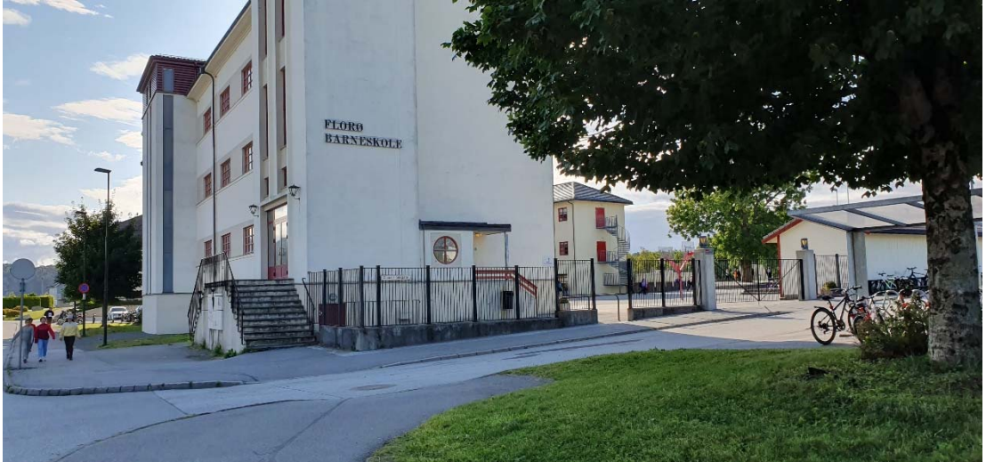
Florø barneskule (1934) vart bygd som eit vinkelbygg, hovuddelen i tre etasjer med kjellar og loft.
