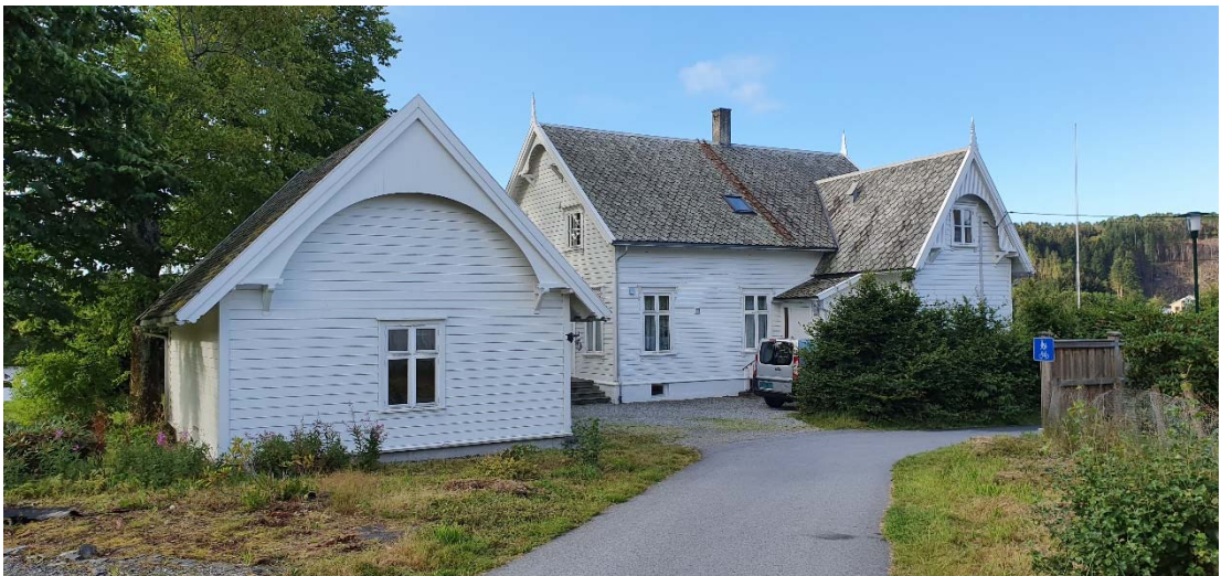
Prestegarden (Øvre Flora) har røter frå middelalderen. Bustadhuset er bygd tidleg 1900-talet og erstattar tidlegare hovudhus som stod der. Garasjen er av nyare dato.
