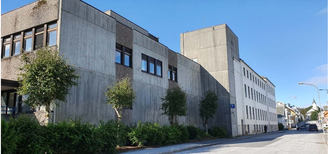
Ingen av bygningsdelane på sjukehuset har eit formelt vern.
