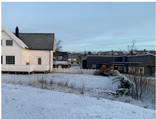
Figur 6 Barnehagen til høyre i bilde. Sett fra sør.
