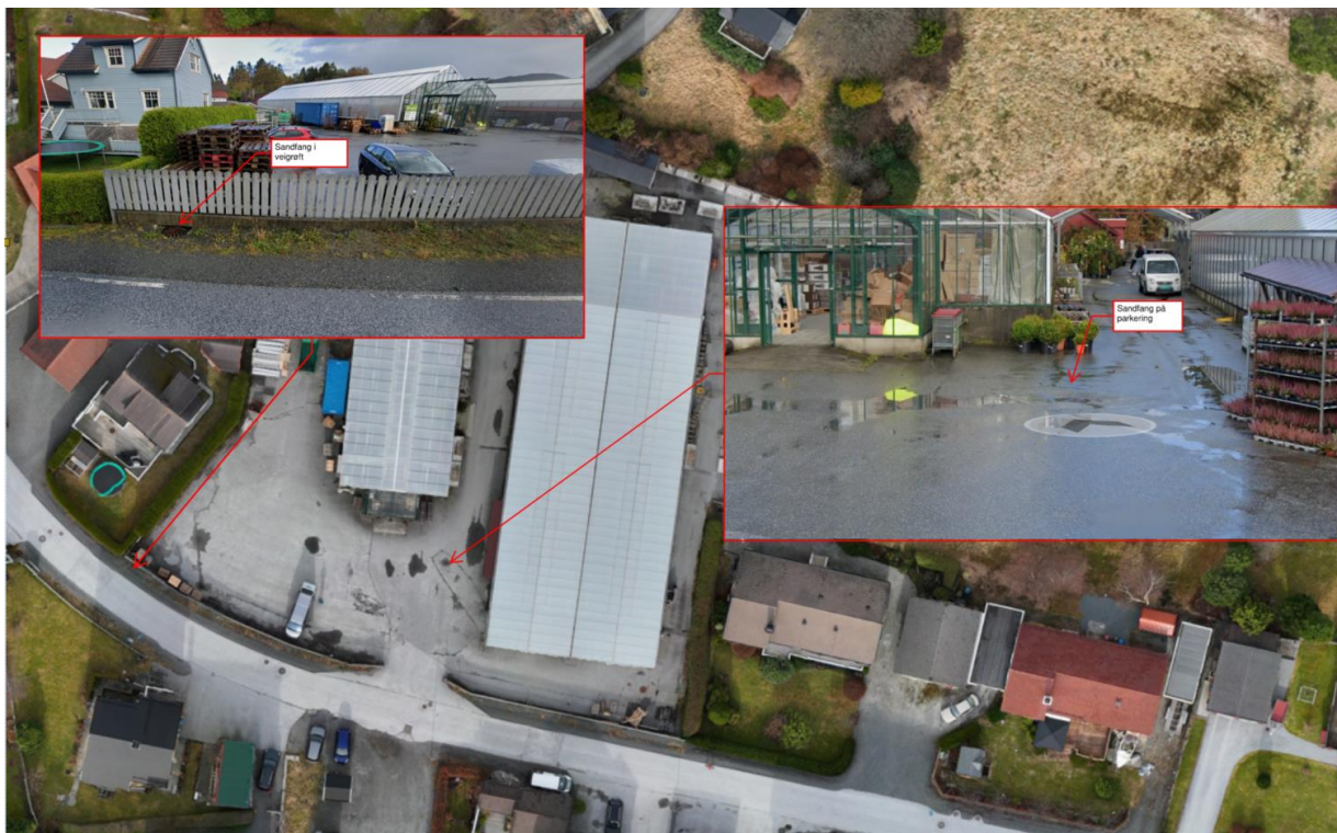
Figur 7: Viser eksisterende overflater og sandfang inne på parkeringsområdet til gartneriet.
