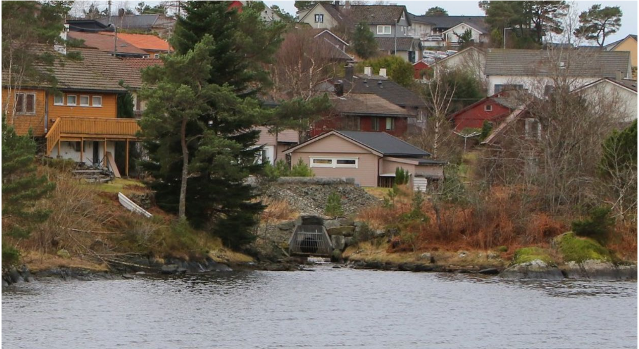
Figur 17: Bilde henta frå Firdaposten som viser utløpet til etablert overvassleiding som er lagt gjennom området ( https://www.firdaposten.no/ny-veg-til-kystmuseet-vi-er-i-dialog-med-naboane/s/5-16-877601 ).
